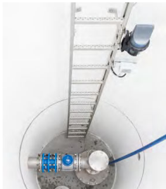
Punto de medida IP68 alimentado por batería con comunicación GSM/GPRS
