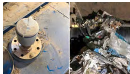
Medida del nivel de residuos plásticos en una planta de tratamiento de aguas
