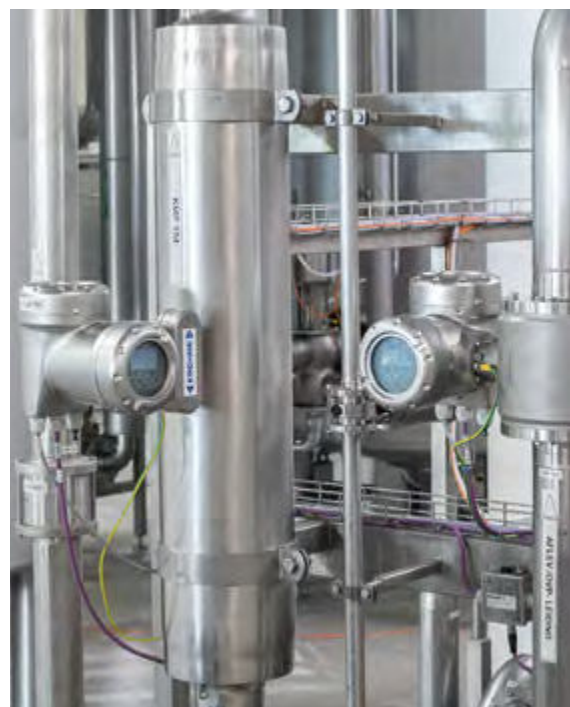
Caudalímetro másico Coriolis de tubo recto OPTIMASS para productos sensibles al efecto cizalla
