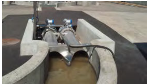
Medida de caudal de aguas residuales en tuberías parcialmente llenas
