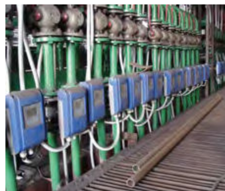
Detección de fugas en líneas de refrigeración de fundiciones y procesos del acero
