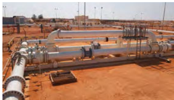
Sistemas de medida de transferencia de custodia para producción de agua
